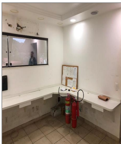
Figura 8.4 - Área administrativa desativada 3
