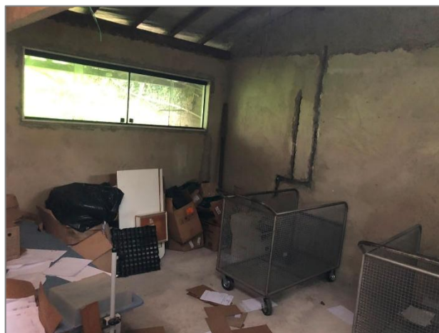
Figura 22 - Sala de entulhos
