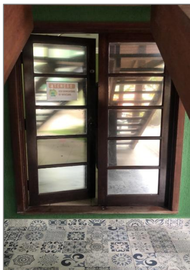
Figura 8.1 – Hall de entrada da área Administrativa desativada
