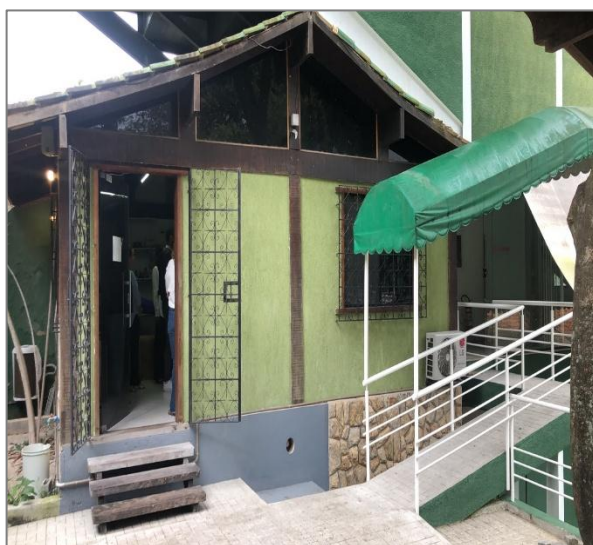
Figura 6.1 – Hall de entrada da área de equipamentos
