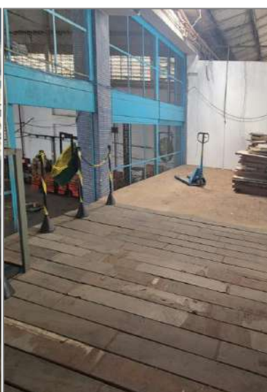
Figura 49.1 – Local em construção para sala de descanso
