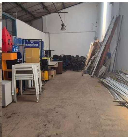
Figura 49.2 – Local em construção para refeitório
