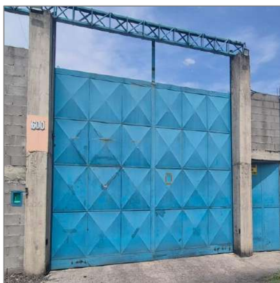
Figura 36 - Portão de acesso ao terreno
