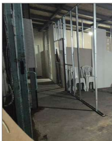
Figura 45.1 – Local em obra
