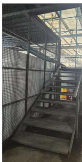
Figura 48 – Escada do térreo para o andar superior
