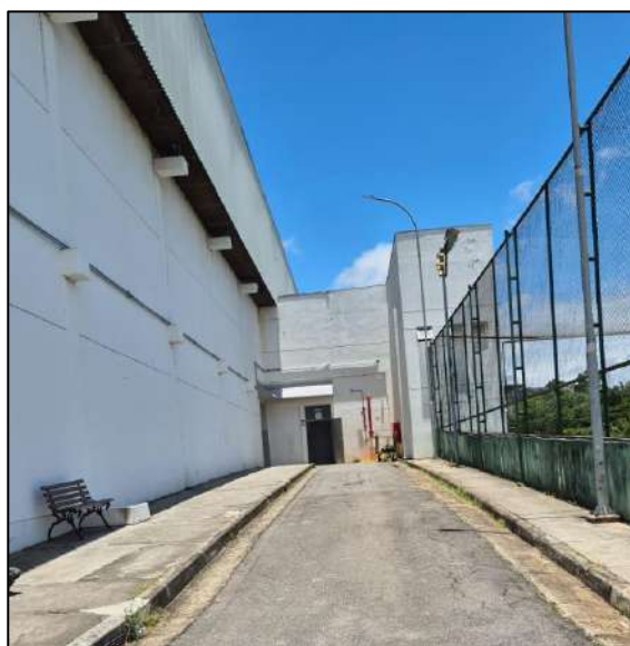
Figura 36.1 – Entrada da Fábrica
