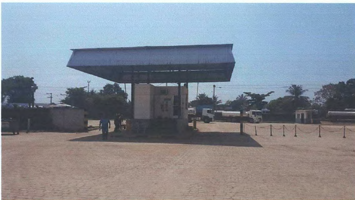
Figura 6 - Cancela de controle de acesso
