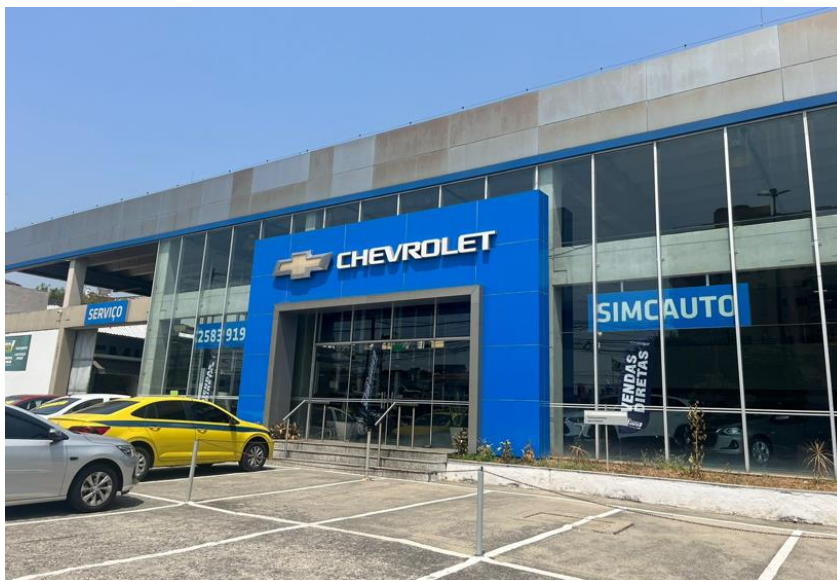
Figura 10 – Fachada da filial Cascadura
