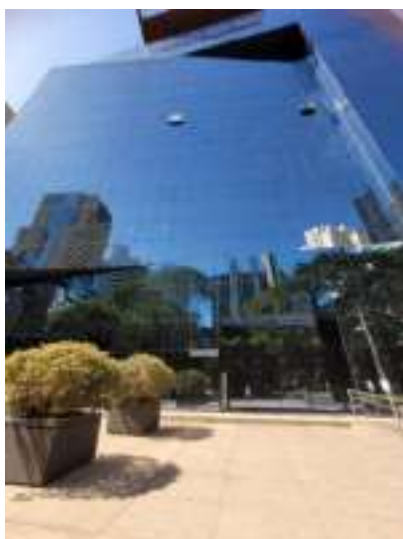
Fachada do prédio comercial em que se situa a sede das Requerentes
