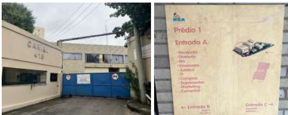
Imagens 1 e 2 – Fachada da sede
