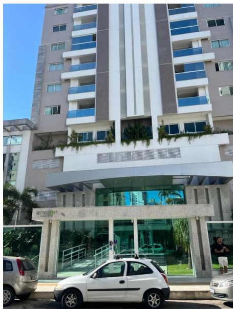
Figura 12 - Entrada Edifício Emotion
