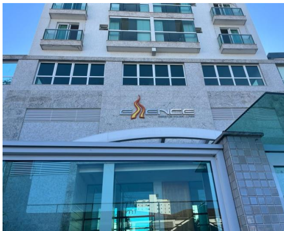
Figura 16 - Entrada Edifício Essence
