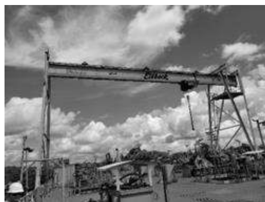
Figura 23 - Ponte rolante Eilbeck Cranes
