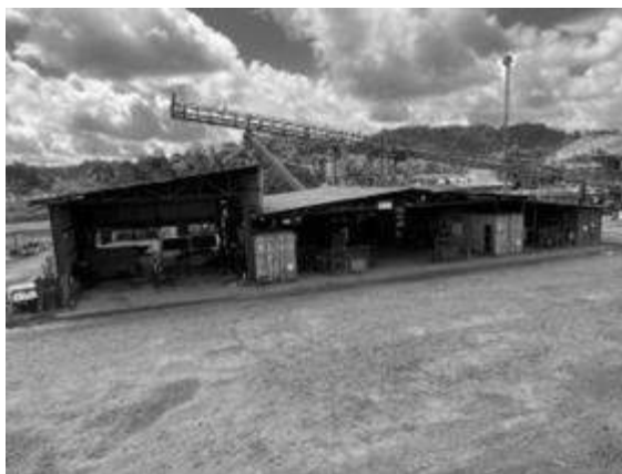
Figura 87 - Galpão manutenção de planta
