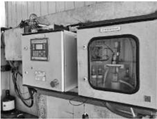
Figura 62 - Analisador Automático de Cianeto
