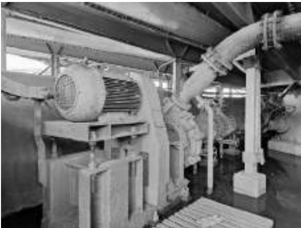
Figura 21 - Bombas Underflow Espessador
