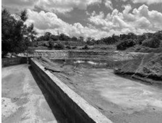
Figura 92 - Reservatório Pond contaminado CIL/DETOX
