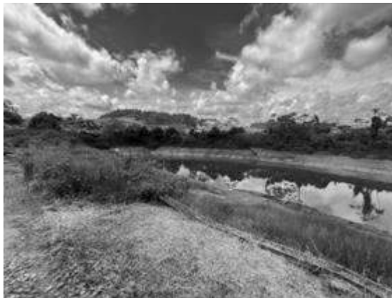
Figura 93 - Reservatório de água do processo
