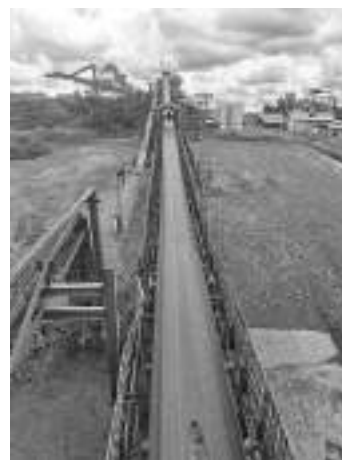
Figura 4 - Correia Transportadora CV-01
