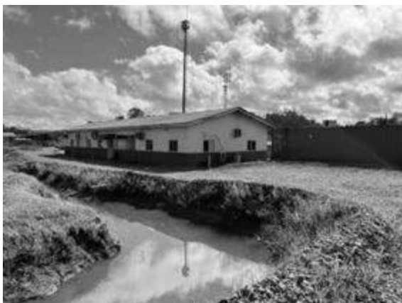
Figura 75 - Manutenção e sala de controle (1)
