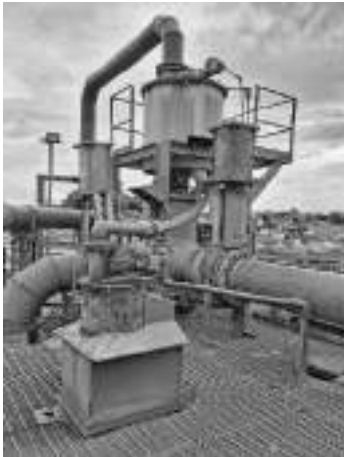
Figura 63 - Amostrador Automático Alimentação
