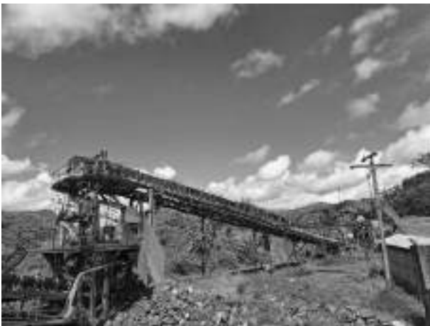
Figura 8 - Correia Transportadora CV-04
